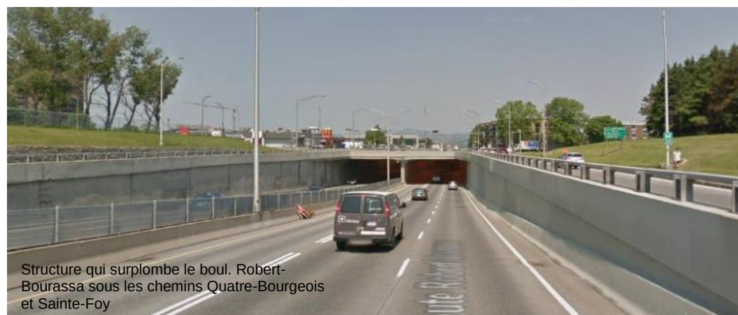
Photo 2 Exemple de structure d'étagement
