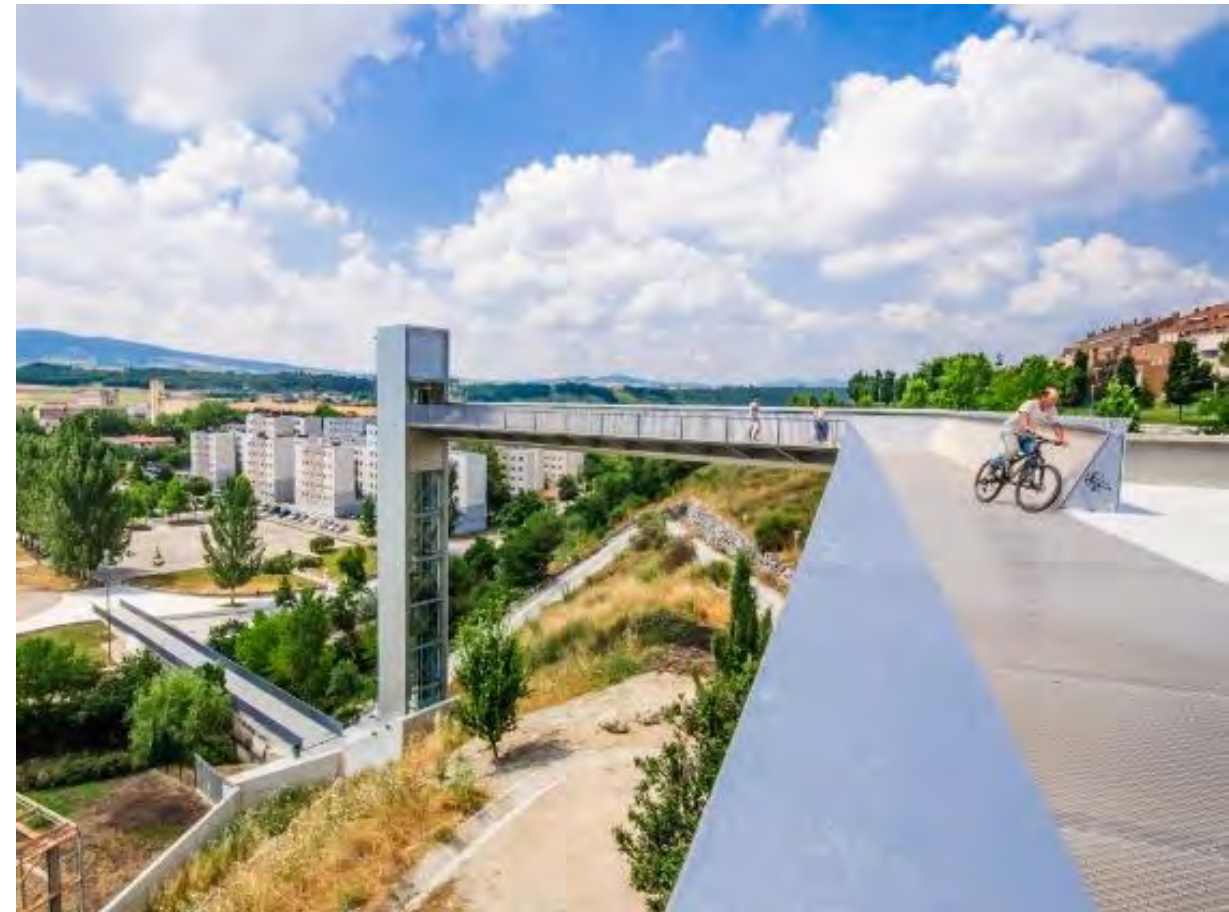
Ascenseur avec passerelle à Echavacoiz, Espagne
