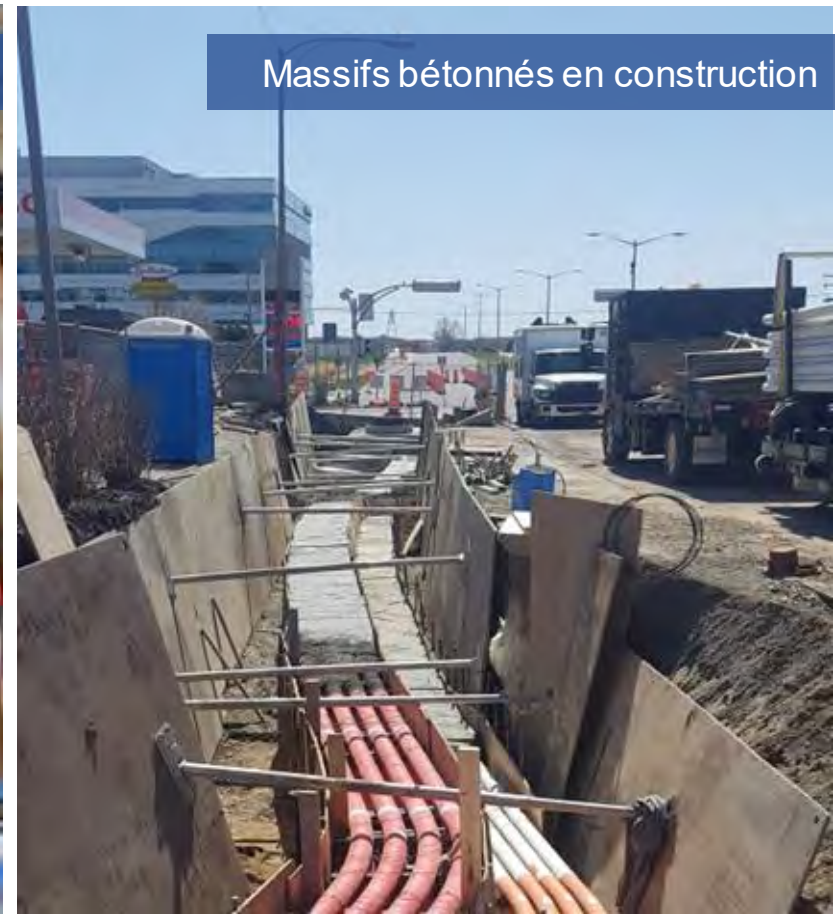
Installation de conduits
