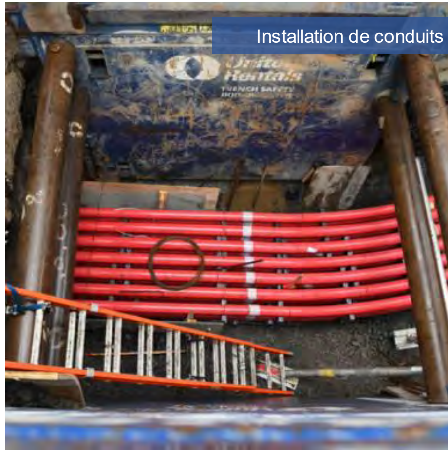
Construction d'un puits d'accès rue de Claire-Fontaine
