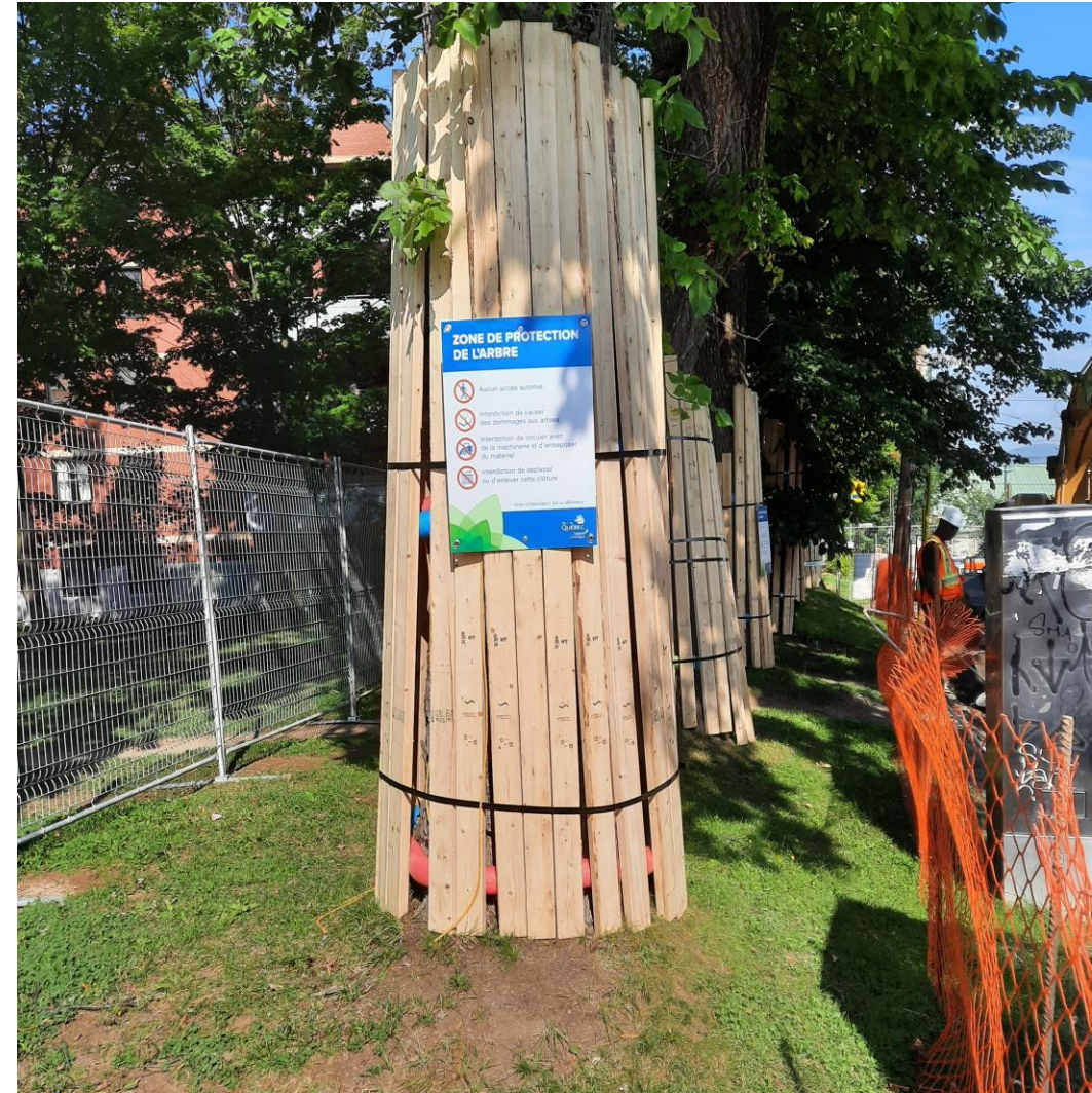
Exemple de mesure de protection sur des arbres
